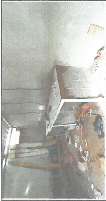
Foto 5: Colocación de azulejos en mesa de semento.
