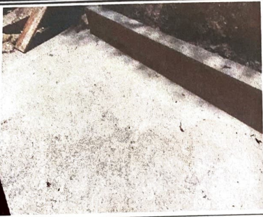
Foto 7: . PISO DE CONCRETO
