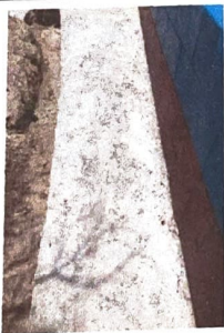
Foto 9: REMOZAMIENTO DE BANQUETA
