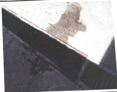
Foto 8: REMOZAMIENTO DE REJILLAS
