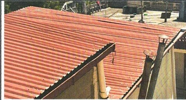
Vista de techo a cambiar por filtracion de agua
