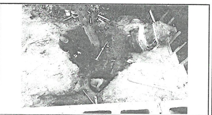
Foto 6: Escavación del suelo para la colocación del biodeigestor.
