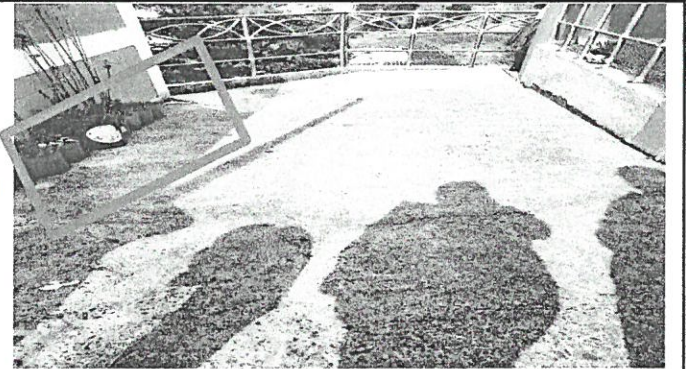
Foto 4: Impermeabilización de muro.
