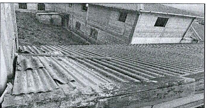
VISTA DE TECHO A REMOZAR
