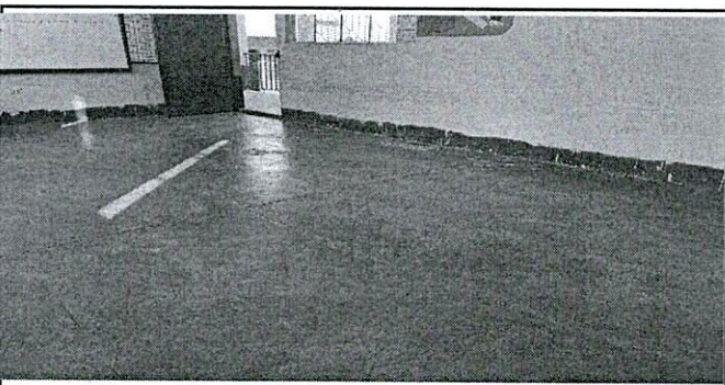
VISTA DE PISO DE AULA A REMOZAR
