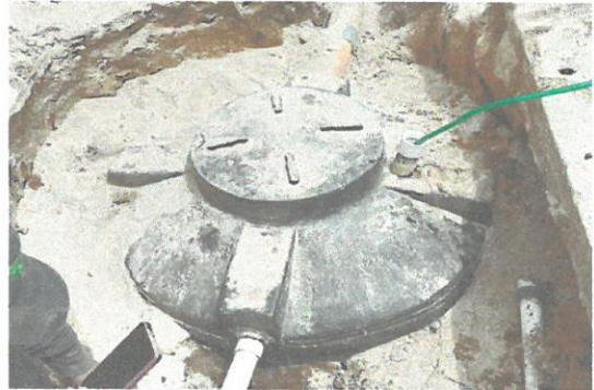
Foto 2: SUSTITUCIÓN DE POZO CIEGO POR SISTEMA BIODIGESTORIO
