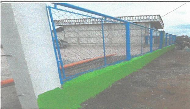
Foto 5: SUSTITUCIÓN DE MALLA ACTUAL POR MALLA GALVANIZADA CON MARCOS METALICOS.
