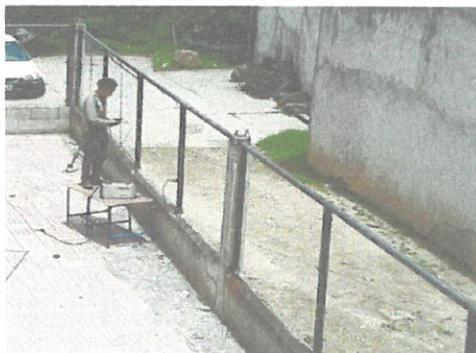
Foto 5: SUSTITUCION DE MALLA ACTUAL POR MALLA GALVANIZADA CON MARCOS METALICOS
