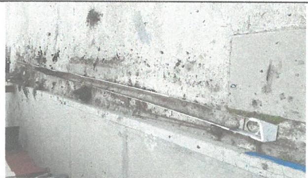
Foto 6: SUSTITUCION DE TUBO DE AGUA PLUVIALES
