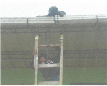
Foto1: SUSTITUCION DE CANALES DE AGUAS PLUVIALES
