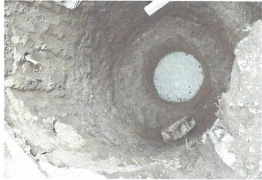
Foto 2: SUSTITUCION DE POZO CIEGO POR SISTEMA BIODIGESTORIO
