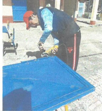
Foto 2: APLICACIÓN DE PINTURA ANTICORROSIVAS A PUERTAS
