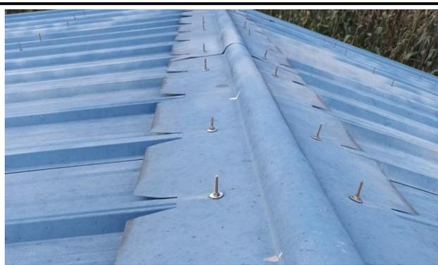
**Foto 4: Proceso finalizado de cambios de tornillos en dos aulas del segundo nivel.**
