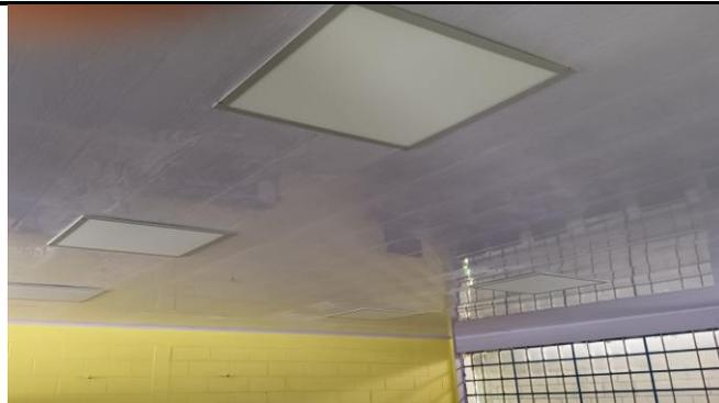
**Foto 2: Colocación completa de cielo falso en dos aulas del segundo nivel.**
