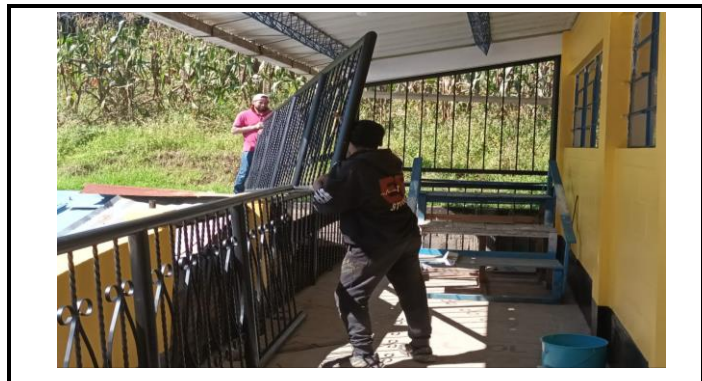
Foto 3: Proceso de la colocación de las barandas.
