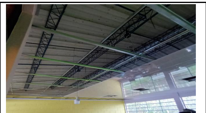
Foto 2: Proceso de colocado del cielo falso en una de las aulas.
