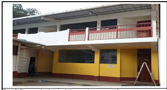
Foto 5: Proceso de pintado de la escuela en su exterior.
