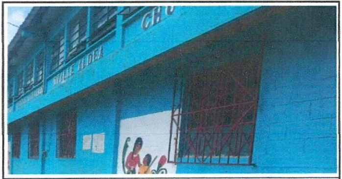
Foto 6: vista de los balcones a pintar
