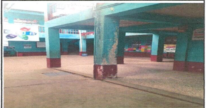
Foto 2: vista de la pared y columnas interiores a pintar
