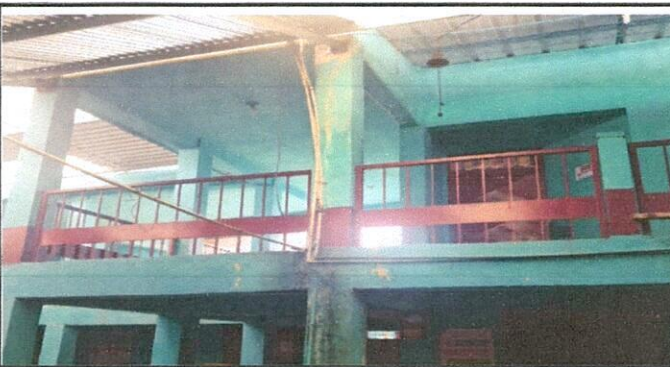
Foto 5: vista de las varandas a pintar
