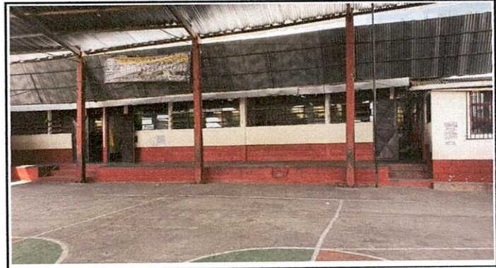
Foto 4: Renglón 4 Pintura Aplicación de Pintura en parales
