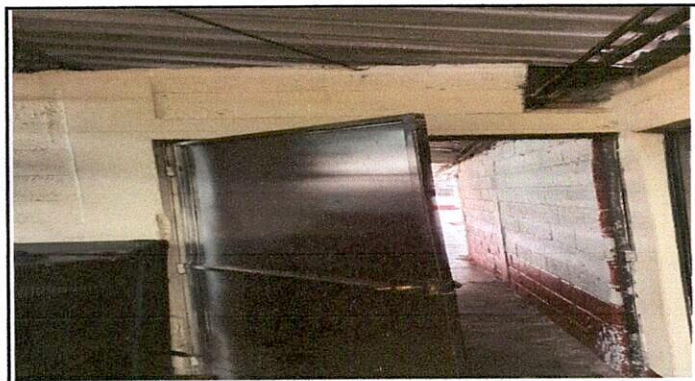
Foto 9: Renglón 9 Puerta: Retiro de puerta de metal
