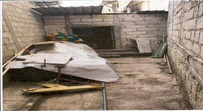
Foto 1: Renglón 1 Techos: instalación de lamina de bodega y cocina y pasillos de baño
