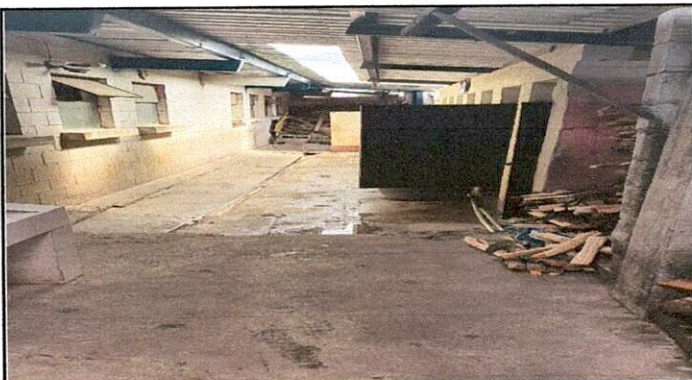
Foto 3: Renglón 3 Piso: relleno con selecto y torta de concreto con mezclon y piso, en bodega, cocina y baño, tallado de bordillo en baños
