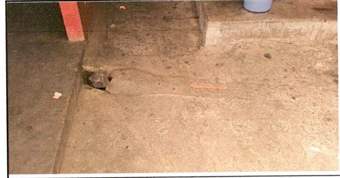
Foto 6: Renglón 6 Drenaje: retiro de pavimento, y colocación de reposadera, colocación de tubería para mingitorio, acondicionamiento de caja de drenaje, y tubería auxiliar para canal de la cocina.
