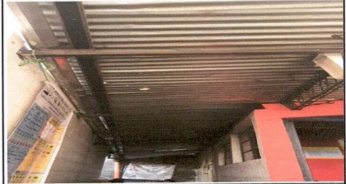
Foto 2: Renglón 2 canales: Retiro e instalación de nuevos canales y tubería auxiliar.
