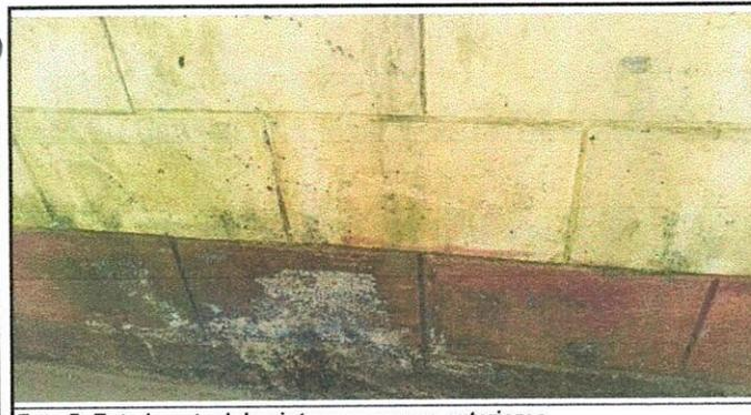
Foto 5: Estado actual de pintura en muros exteriores.
