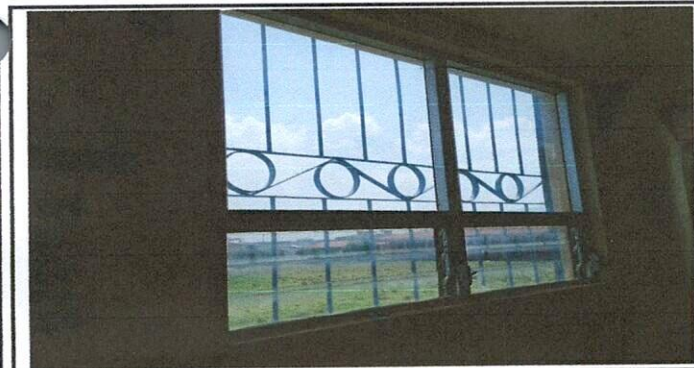
Foto 5: Colocación de balcon interno en cada una de las ventanas de la dirección en su primer nivel, para prevenir el robo en el mismo debido a que ya ha sido objeto del mismo en dos ocasiones.
