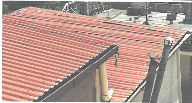
Vista de techo a remozar
