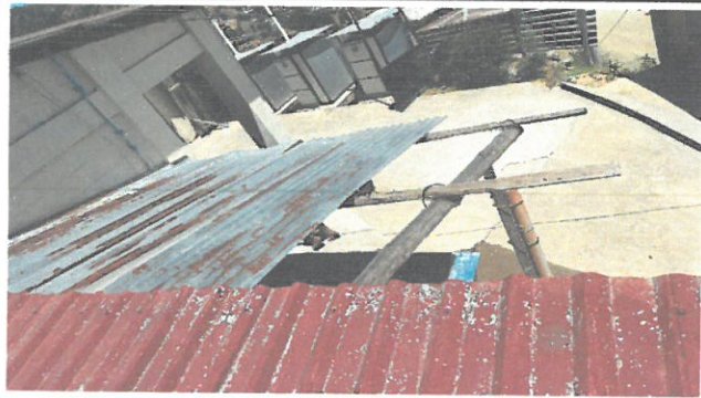
Vista de galera a sustituir
