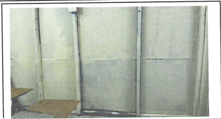
Vista de interior de aula a remozar
