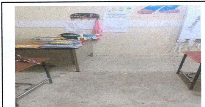
Foto 9. colocación de pizo en aula de preprimaria y repello de paredes.
