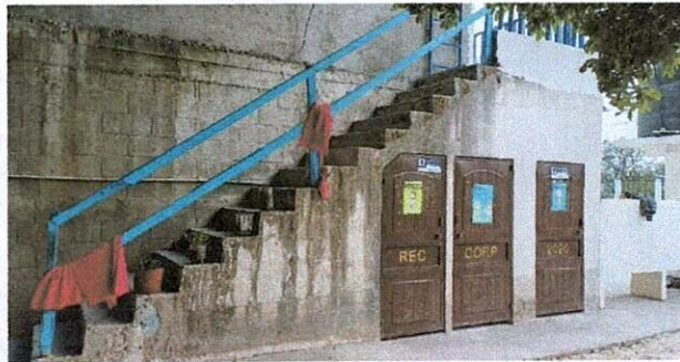
Foto 2: barandas de metal para las gradas que llevan al segundo nivel, repello de paredes.
