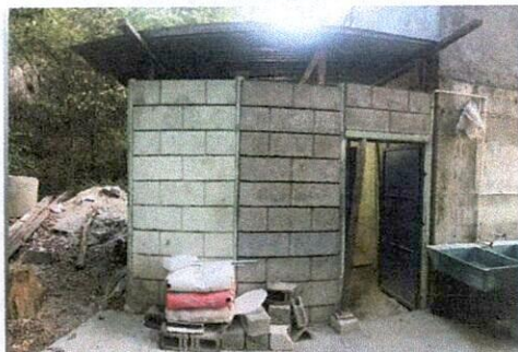
Foto 5: Cambio de puerta de la cocina.
