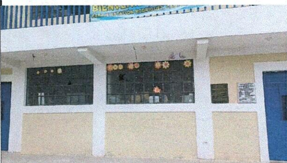
Foto 3: Reparación de vidrios rotos y colocación de balcones para las ventanas de la parte del primer nivel.
