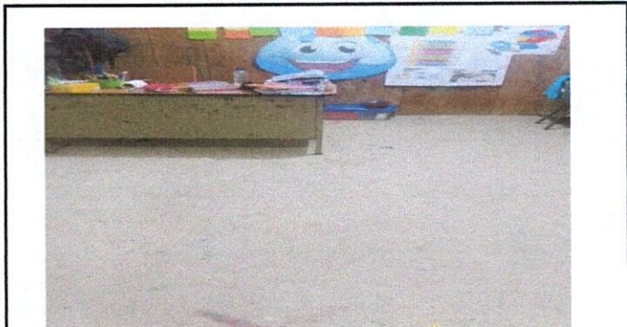
Foto 8: colocación de pizo en aula de primer grado y repello de paredes.
