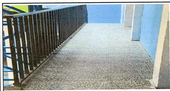
Foto 5: Modulo 3.1 complemento de baranda segundo nivel.
