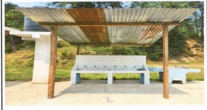
Foto 2:Region 2.1 Sustitucion de estructura y techo area del lavamanos
