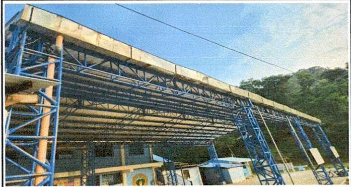
Foto1: Region 1.1 Sutiución sistema de canales pluviales
