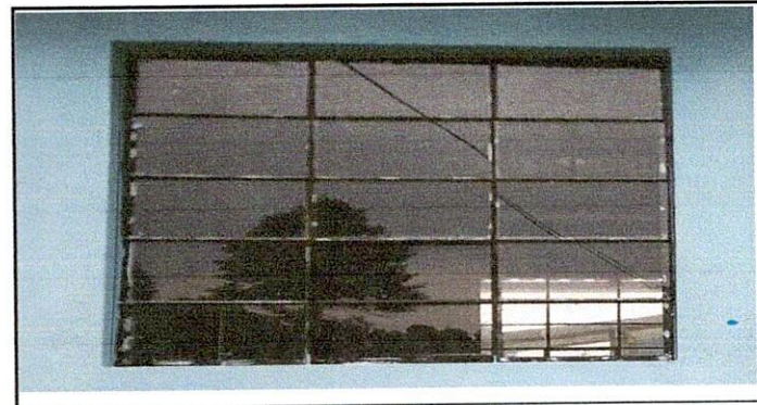
Foto 6: modulo 4.1 implemetacion de balcones 3 valcones de la cocina y una del aula de parvulos.
