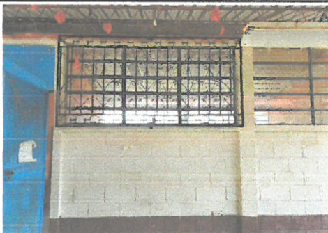
Foto 5: balcon de 1 ventana en el corredor de la escuela
