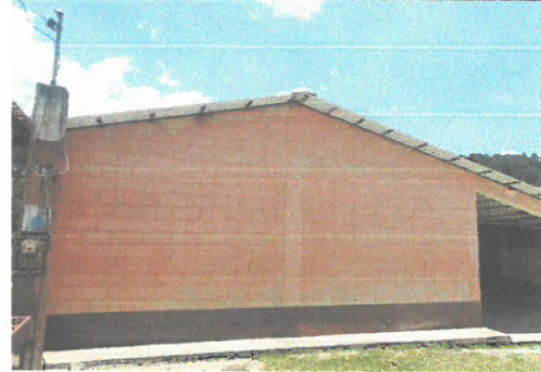
Foto 2: parte frontal de la escuela con techo nuevo
