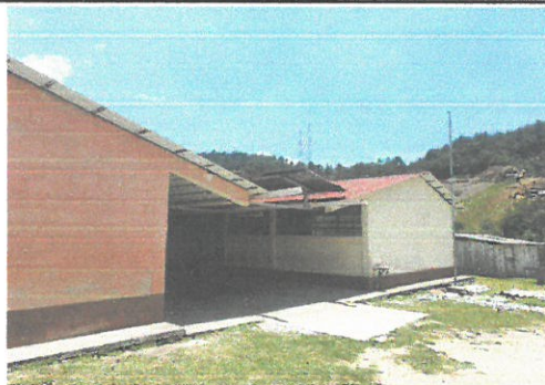
Foto 3: parte frontal de las aulas de la escuela con techo nuevo
