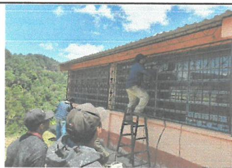
Foto 6: colocada de balcones de 2 ventanas exteriores o traseras de la escuela.
