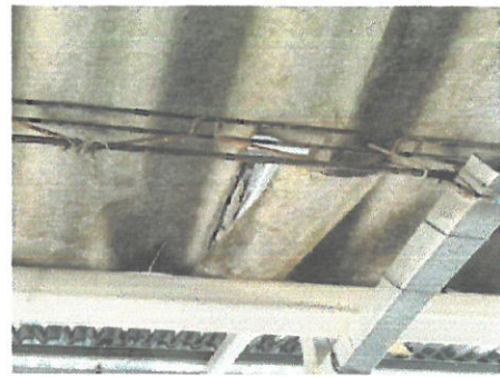
Foto 2: techo del recorridor del establecimiento a remozar
