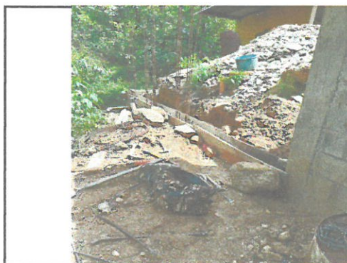
Vista del area a remozar muro de contención
