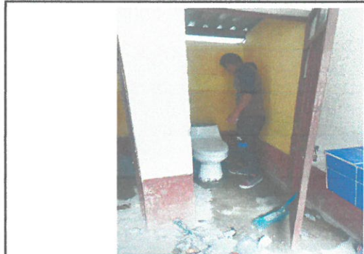
Fotos de area a remozar inodoros y depósito
