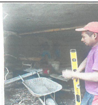
Vista del área a remozar piso y repellido de bodega
