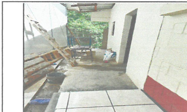
Fotos de area a remozar corredor instalacion de piso de ceramica
