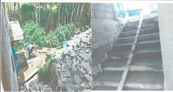
Fotos de area a remozar, construccion de gradas
