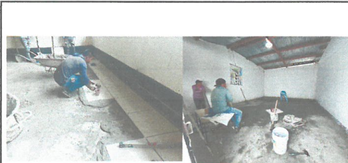
Fotos de area a remozar piso aulas y en direccion
