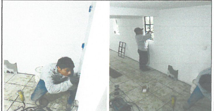
Fotos de area a remozar, instalacion de puerta y ventanas de la bodega.
