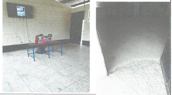
Fotos de area a remozar piso aulas y en direccion
