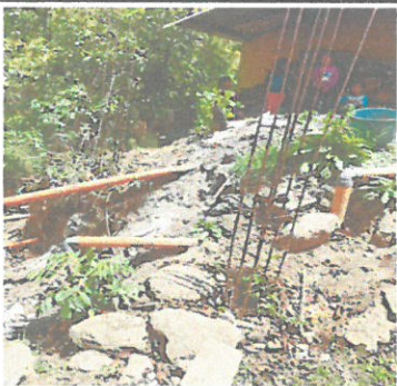
Vista del area a remozar muro de contención
