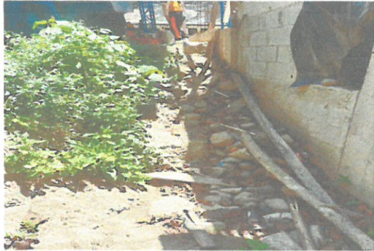
Fotos de area a rezozar, construccion de gradas
