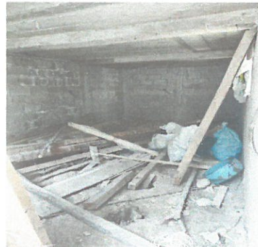
Vista del área a remozar piso y repellido de bodega
