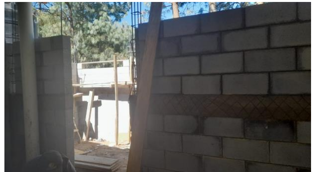
Reforzamiento de mocheta de 0.14x0.10 m (3000psi)
