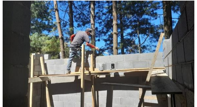
Reforzamiento de columna de concreto
