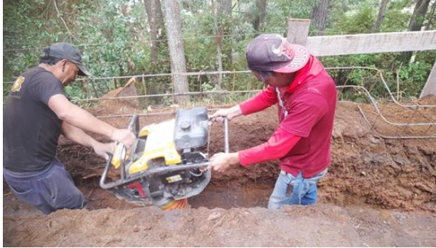
Tratamiento de suelo de cimentación con aditivo en área de sanitarios
