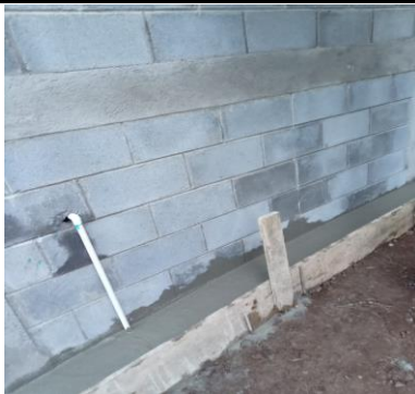
Reforzamiento de banqueta (espesor 10 cm)
