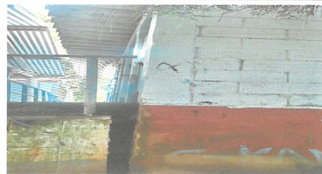
Simentación de módulo de baño.
