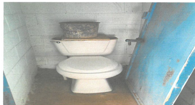
Sustitución de artefactos de servicios sanitarios
