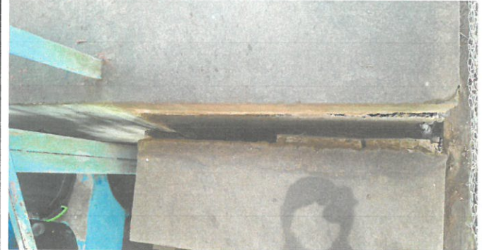
Derribación de las gradas para quel modulo quede al nivel del suelo.
