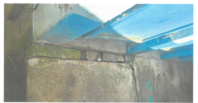
Sustitución del concreto que adhiere el modulo de baños al establecimiento.
