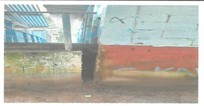
Reconstrucción de módulo de baño al nivel del suelo.
