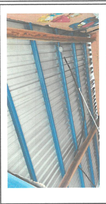
Foto 2: Sustitución de estructura portante de madera, por costaneras de metal de 2 aulas
