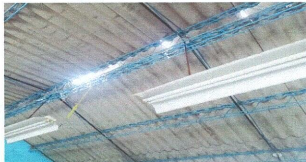
Foto 2: situación actual de la estructura de metal.
