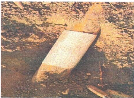
Cambio de Tubo de pvc de drenaje
