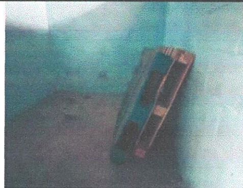
Area donde se instalara piso porcelanato
