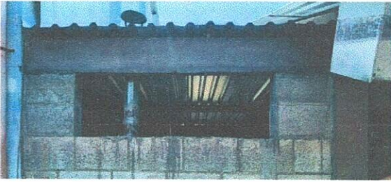
agregar dos block en cada extremo y solera final
