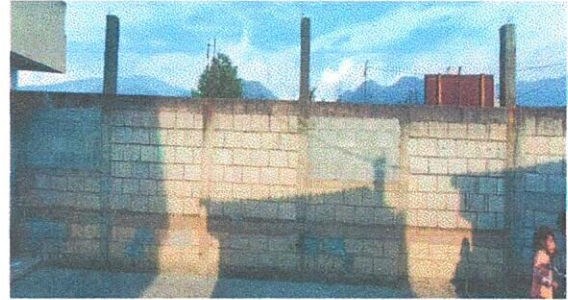
Remozamiento de muro de block existente con malla
