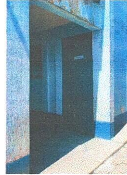
Area para instalacion de puerta corrediza
