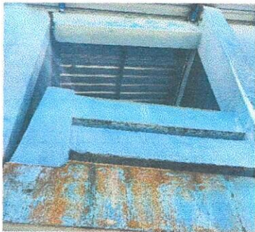
Area de pasillo en segundo nivel para instalacion de ventana
