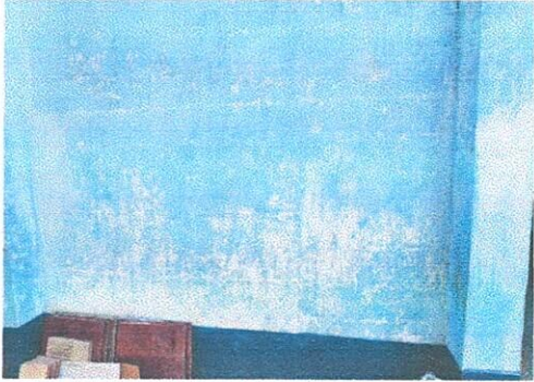
aplicación de pintura
