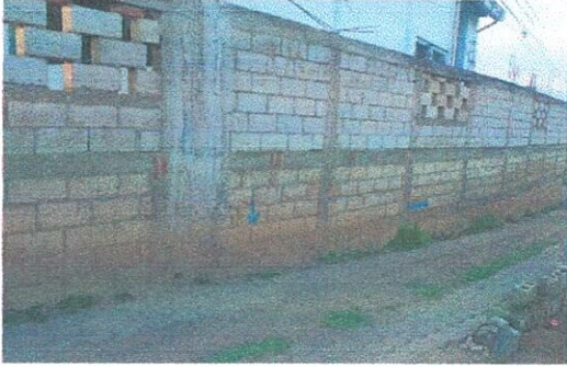
Remozamiento en areas abiertas en muro de circulacio de block existe
