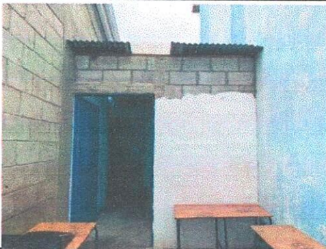
Area de sustitucion de lamina acanalada por lamina troquelada
