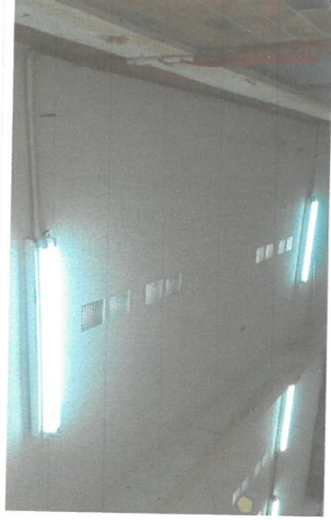
Foto 4: Sustitución de lámparas quemadas por nuevos adquiridos incluyendo suministros materiales y mano de obra.
