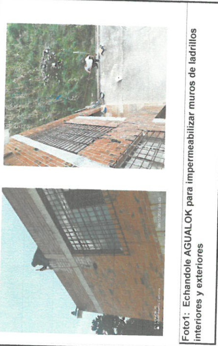
Foto 2: Echándole AGUALOK para impermeabilizar muros de ladrillos interiores y exteriores.
