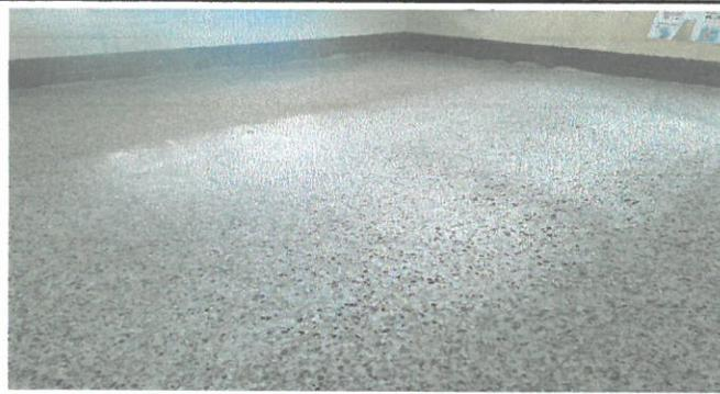
Foto 1: Fotografía mostrato instalación de piso de granito en las aulas
