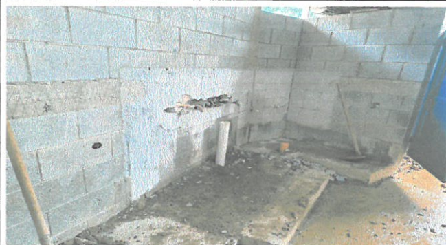
Foto 3: Fotografía de remodelación de lavamanos
