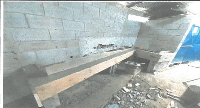
Foto 4: Fotografía del armado del nuevo lavamanos
