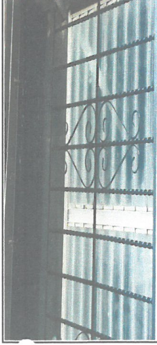
Foto 11: Remozamiento de ventana con la instalacion de balcones
