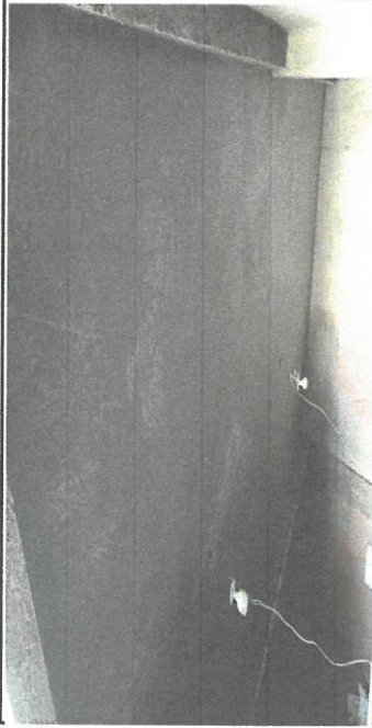
Foto 1. Suministro y aplicación de repello en muro (módulo de cocina).
