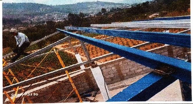
Foto 2: Vista exterior del techo a remozar
