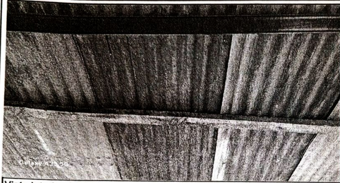
Vista interior del área a remozar techo tanto estructura como cubierta
