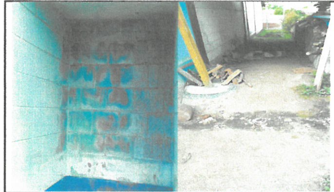
Foto 2: Area a remozar y pavimentar
