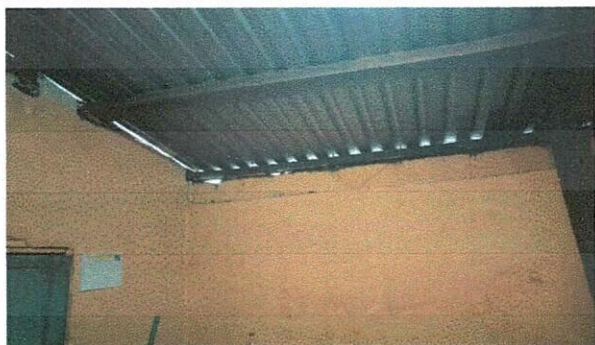
Foto 3: Estado actual del repello en el área de cocina.
