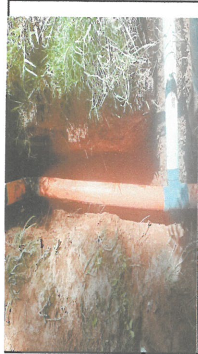
Foto 4: Remozamiento red de Drenaje.
