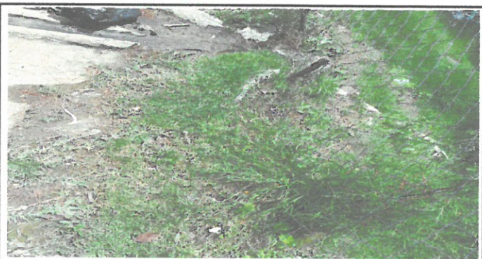
Foto 4: Remozamiento red de Drenaje.
