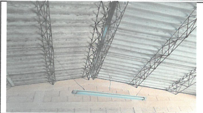
Foto 2: Reparación Sistema Eléctrico
