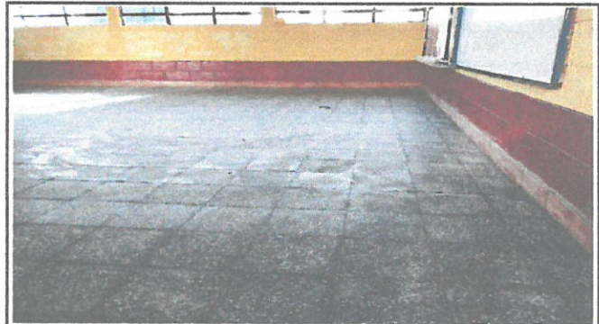
Foto 4: Sustitución de piso de cemento por piso de granito.
