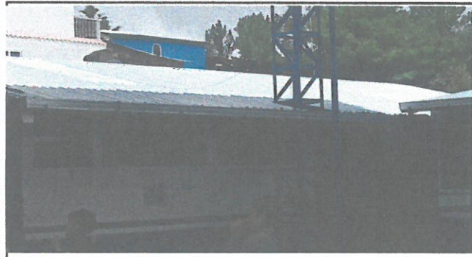
Foto1: Culminación de cubierta de lámina de dos aulas.
