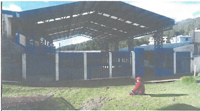
Foto 3: Sustitución total de la maya a barandas metálicas de toda la circulación.
