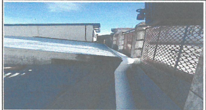
Foto 2: Cambio de canales y bajadas de agua pluvial de dos aulas.
