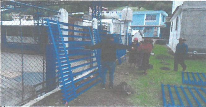
**Foto 3: Se esta instalando el cambio de maya alambrada por baranda metálicas**
