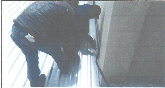
**Foto1: Se estar realizando cambio de lámina de canalada a troquelada**
