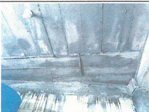
Foto 3: Estado de las paredes y terraza del modulo 1
