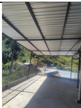
Foto1: Instalación de techo de metal y plafoneras con focos
