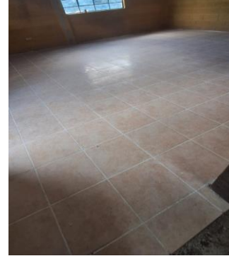
Foto 8: Colocación de piso cerámico en 2 aulas
