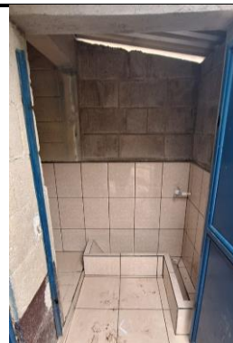
Foto 4: Colocación de azulejo en 3 baños y creación de un mingitorio
