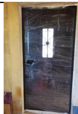
Foto 2: Sustitución de 7 puertas de madera por puertas de metal
