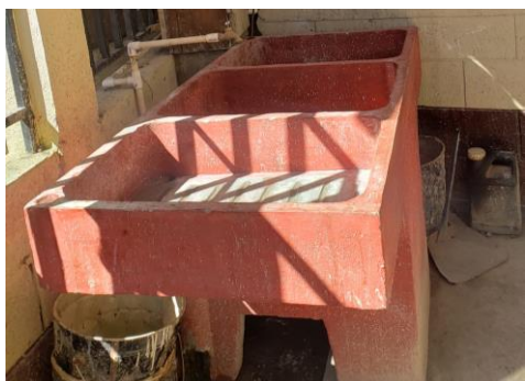
Foto 3: Sustitución de pila
