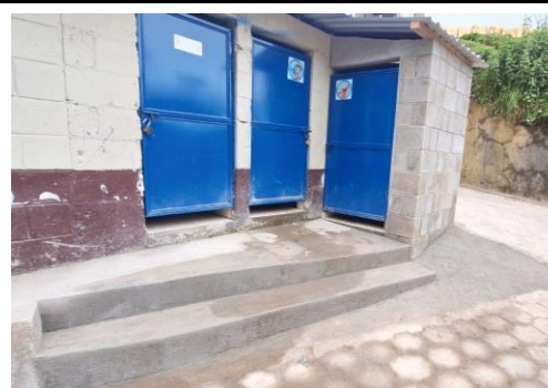
Foto 6: Relleno de espacio y colocación de grada
