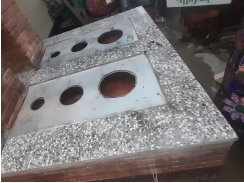
Foto7: Sustitución de planchas y colocación de piso en plancha
