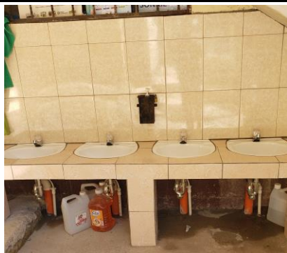
Foto 5: Sustitución de 4 lavamanos y colocación de azulejo
