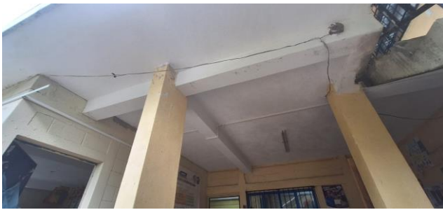
Foto 9: Cubierta de cableado con canaletas
