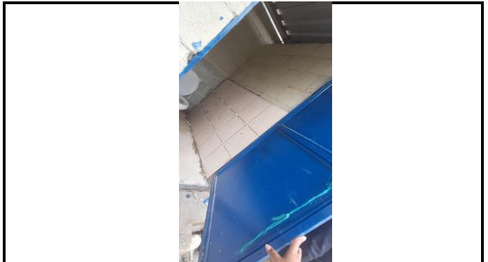
Foto 4: Colocación de azulejo en baño
