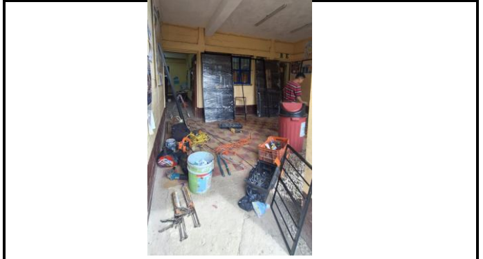
Foto 2: Instalación de puertas
