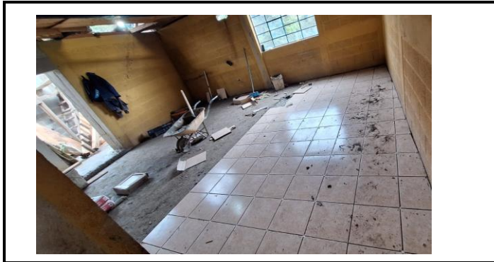
Foto 5: Colocación de piso en dos aulas
