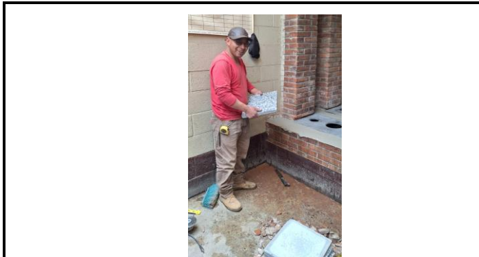
Foto 3: Colocación de piso y plancha en cocina
