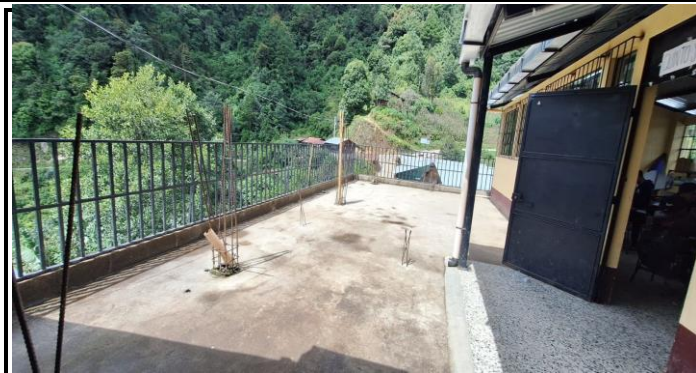
Foto 1: Vista de patio en donde se remozará con techo de estructura metálica
