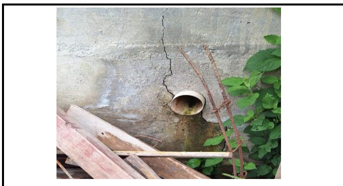
Foto 12: Reparación de drenaje en cocina en la parte trasera
