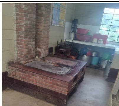
Foto 17: En cocina, remozamiento de plancha y colocacion de piso en plancha
