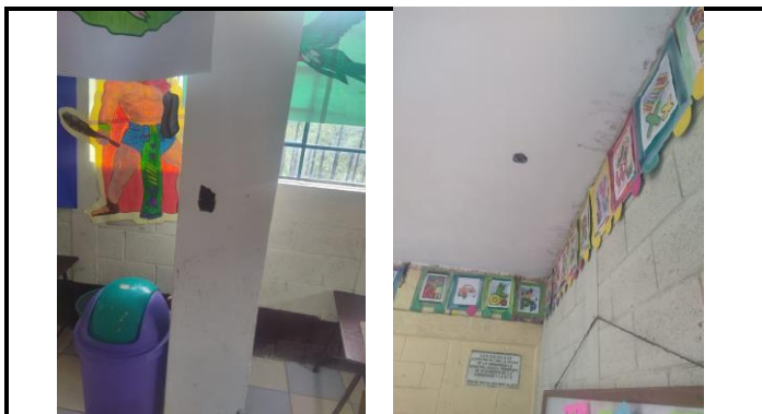
Foto 9: Aula de preprimari para instalación electrica
