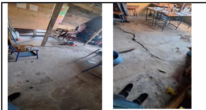
Foto 11: En aula trasera sustrucción de piso
