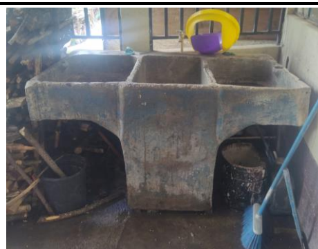
Foto 18: En cocina sustitucion de pila y chorro
