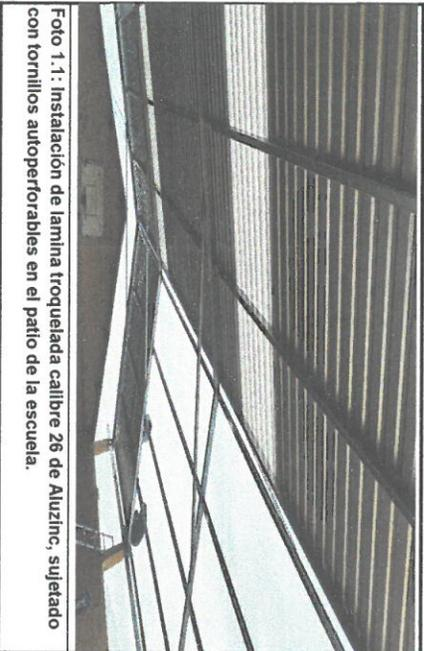
Foto 1.1: Instalación de lamina troquelada calibre 26 de Aluzinc, sujetado con tornillos auto perforables en el patio de la escuela.
