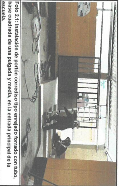
Foto 2.1: Instalación de portón corridiso tipo enrejado forrado con tubo, base cuadrada de una pulgada y media, en la entrada principal de la escuela.
