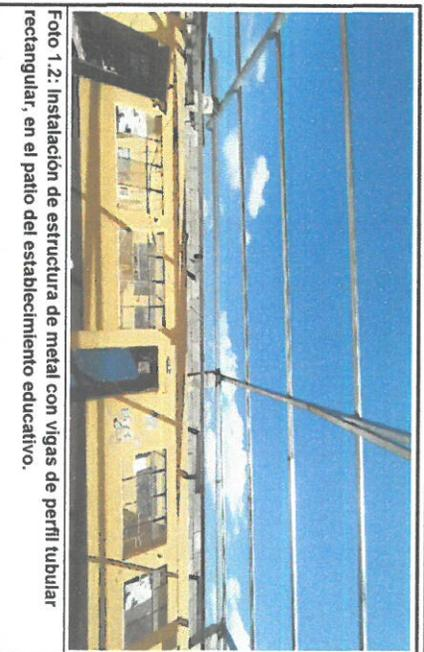
Foto 1.2: Instalación de estructura de metal con vigas de perfil tubular rectangular, en el patio del establecimiento educativo.
