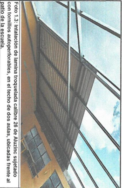
Foto 1.3: Instalación de lamina troquelada calibre 26 de Aluzinc sujetado con tornillos auto perforables, en el techo de dos aulas, ubicadas frente al patio de la escuela.
