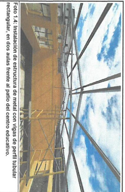
Foto 1.4: Instalación de estructura de metal con vigas de perfil tubular rectangular, en dos aulas frente al patio del centro educativo.
