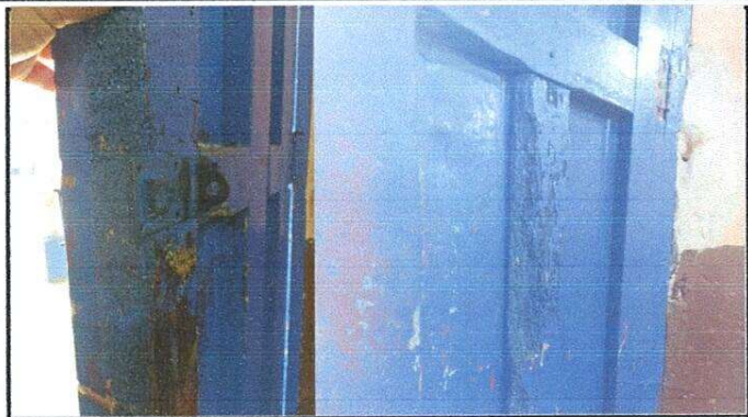
Foto 2: Restauración, tratamiento, accesorios y barnizado con poliuretano para exterior de puertas. Presenta daños en ambos centros de tableros y largueros por polilla, varios orificios ocasionados por el cambio constante de pasadores, alabadas.
