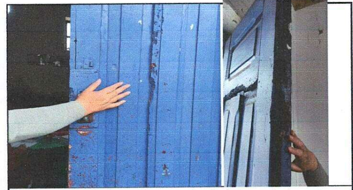
Foto 6: Restauración, tratamiento, accesorios y barnizado con poliuretano para exterior de puertas porque presenta daños en ambos largueros y daños estructurales por polilla.
