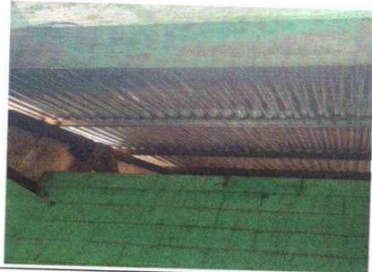
Foto1: Sustitución de cubierta de techo de lamina y estructura de techo.
