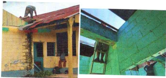
Foto 1: Sustitución de cubierta de techo de lamina y estructura de techo.
