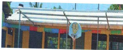
Foto 2: sustitución de cubierta de techo de lamina y estructura de techo.
