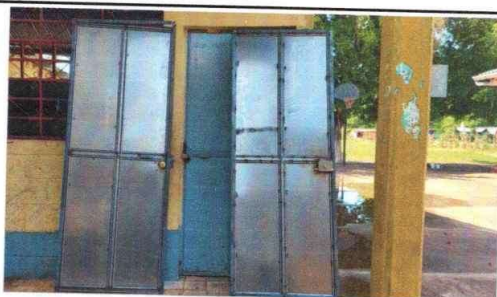
Foto 5: sustitución de puertas
