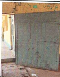
Foto 4: reparación de puerta
