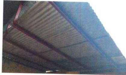
Foto 2: sustitución de cubierta de techo de lamina y estructura de techo.
